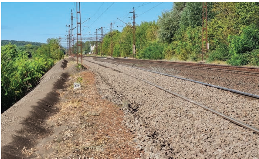
2. ábra. Ágyazatrostálás Biatorbágy–Herceghalom között
