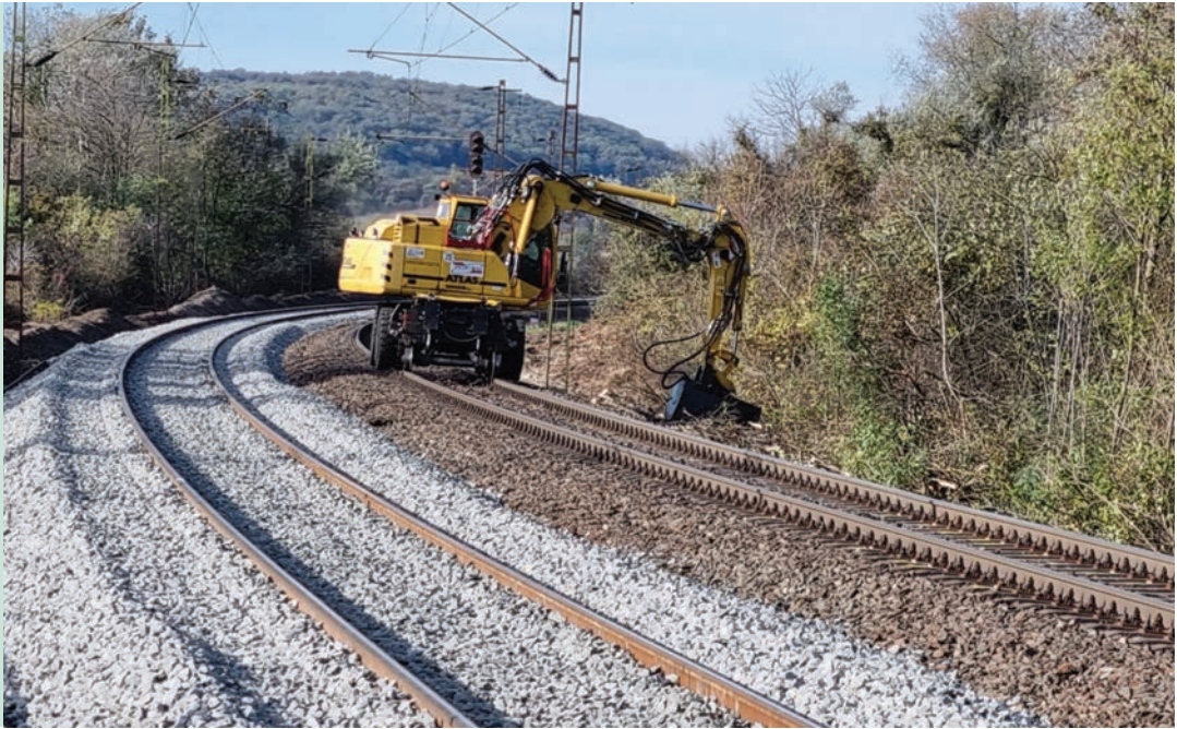
11. ábra. Tarvágás kételtű mun- kagéppel Szár megállóhely térképében
