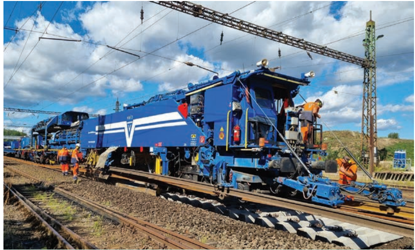
5. ábra. Felépítménycsere átépítő vonattal Bicske–Szárliget bal vágányon
