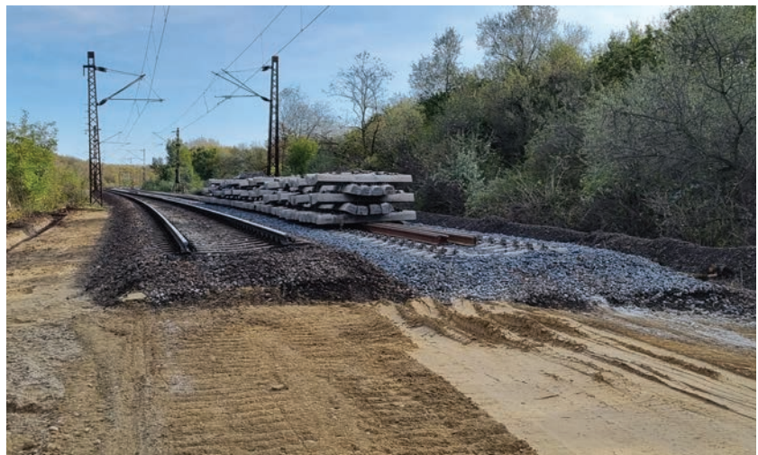
7. ábra. Elbontott vasúti pálya Bicske–Szárliget 562–565. szelvényei között teljes kizárás alatt
