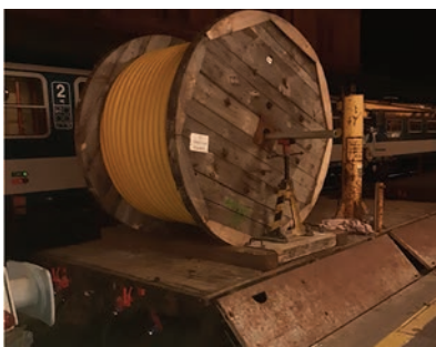
13. ábra. A kábeldob vasúti szállító-járművel történő beszállítása
