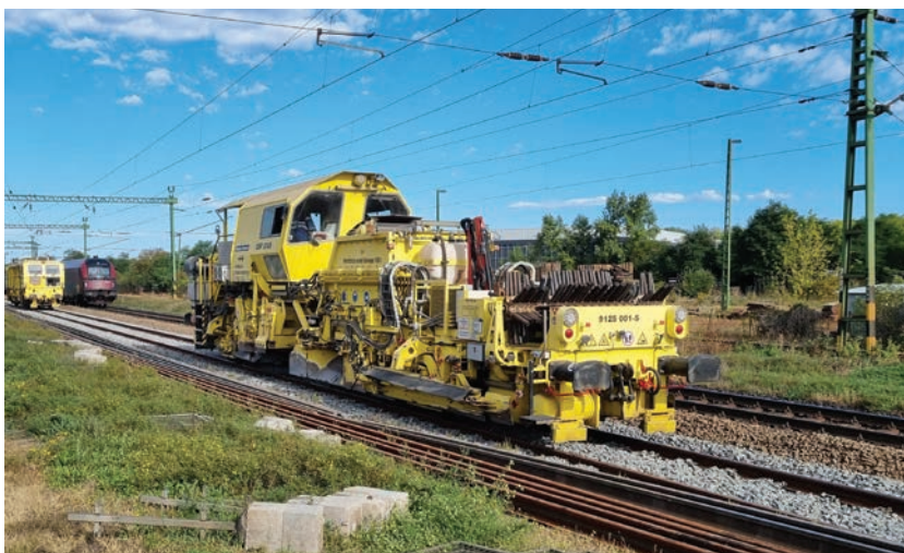
4. ábra. Vágányszabályozás Biatorbágy állomás bal átmenő fővágányán
