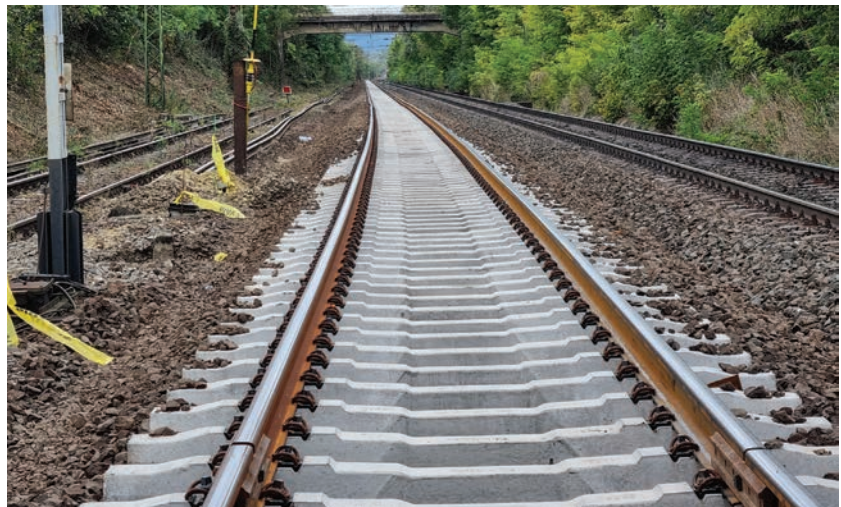
6. ábra. A lefektetett új vágány Bicske–Szárliget között a bal vágányon
