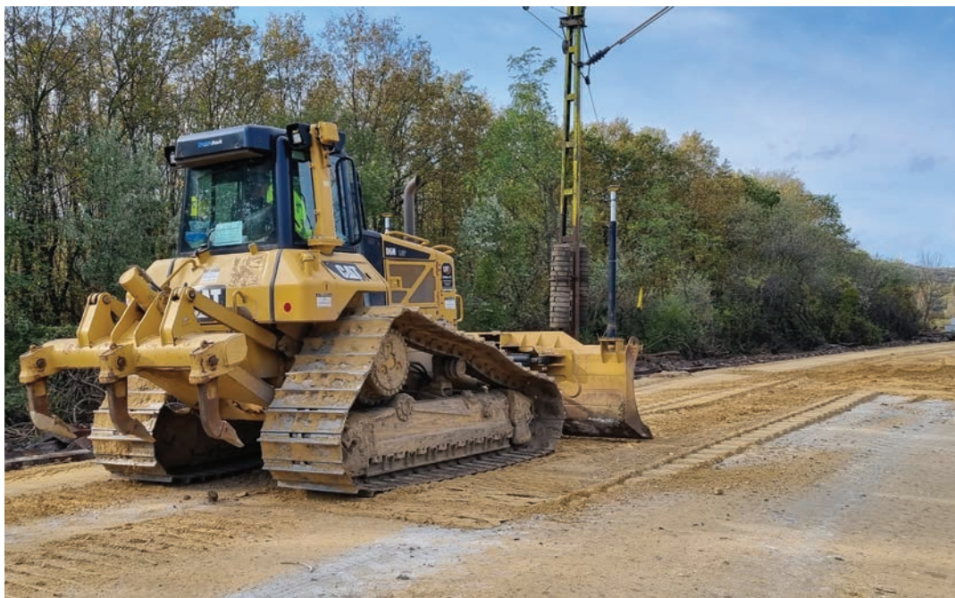
8. ábra. Alépitmény-ja- vítás Bics- ke–Szárliget 562–565. szel- vényei között teljes kizárás alatt
