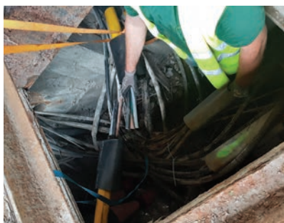
12. ábra. Betápláló kábelek behúzása
