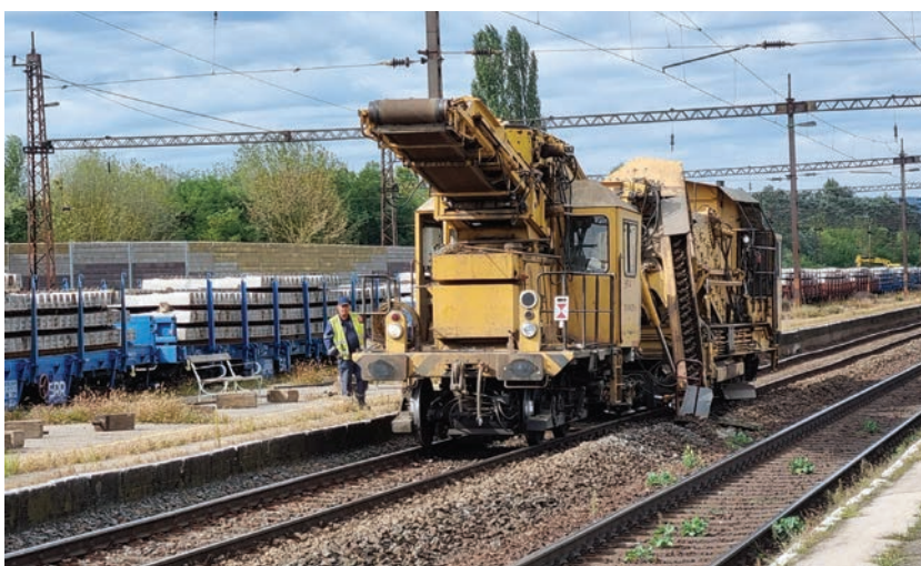
3. ábra. Ágyazatrostálás Bicske bal átmenő fővágányán
