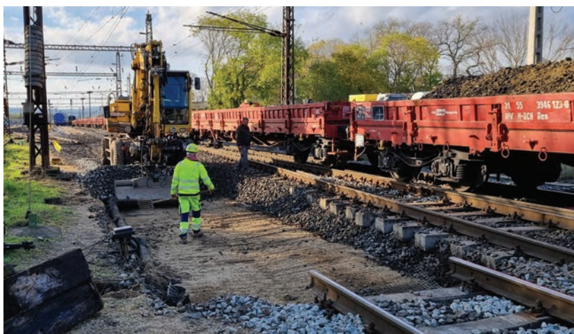
9. ábra. Ágyazatszere kitérőben Bicskén
