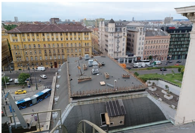
4. ábra. A hő- és füstelvezető ventilátor az A épület tetején
