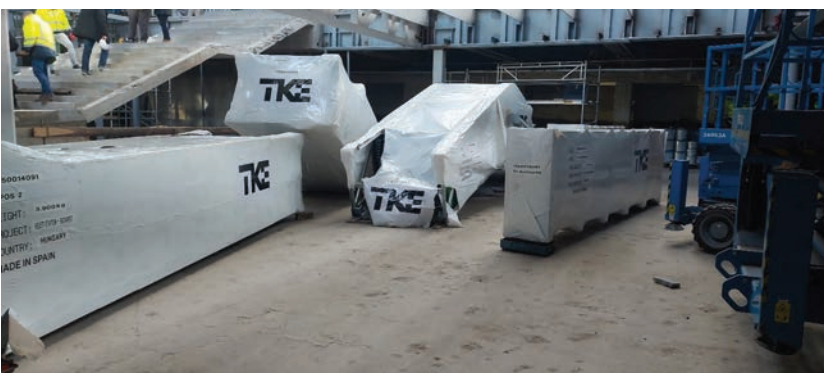
6. ábra. A mozgólépcső elemeinek beemelése az aluljáróba és a munkaterületre deponálása
