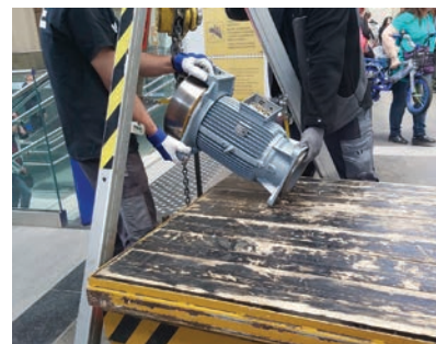
10. ábra. Mozdólépcső felső hajtómotorjának elszállítása
