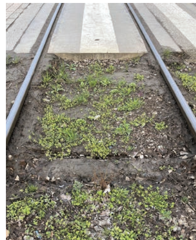
4. ábra. Vízszák a vizsgált szakaszon. (Saját fotó)
