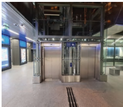
8. ábra. A hívóabló és a taktilis sáv a kiegészítő kontrasztelemekkel
