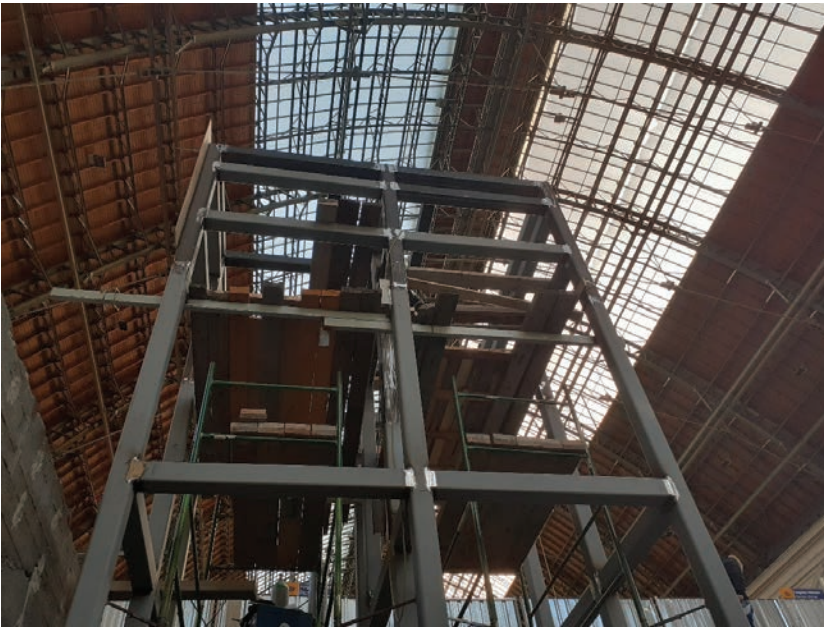
4. ábra. Felvonótorony acél vázszerkezete kivitelezés közben
